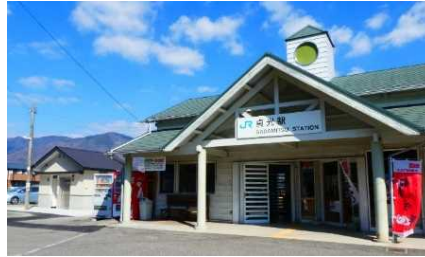
貞光駅公衆トイレ(左)
